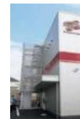
【屋上につながる外階段】
