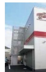
【屋上につながる外階段】
