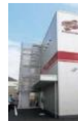
【屋上につながる外階段】 52
