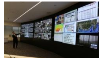
【テレビ会議システム(非常事態対策室内)】
