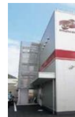
【屋上につながる外階段】
