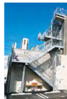
屋上へつながる外部階段
