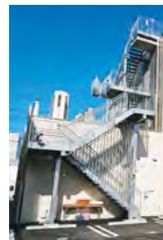
屋上へつながる外部階段
