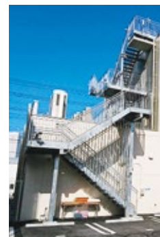
屋上へつながる外部階段
