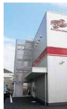
屋上へつながる外部階段
