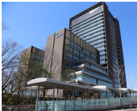
【しずぎん本部タワー】（静岡市清水区）
