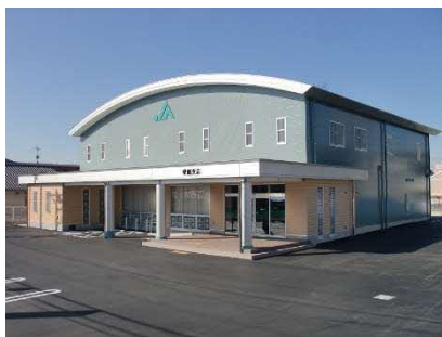
建設事業 (金融機関店舗)
